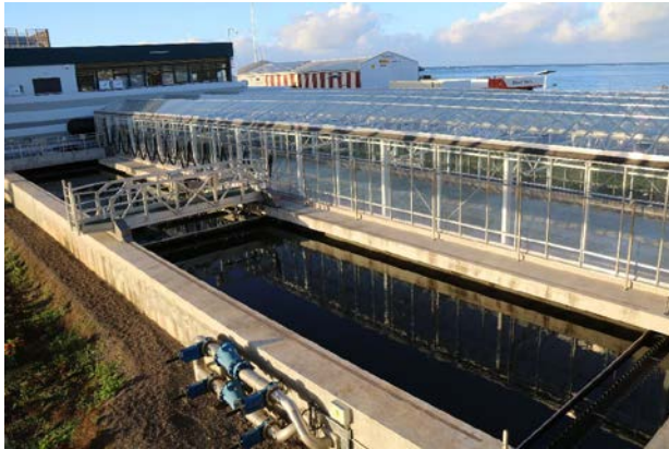
Le cœur de la station d'épuration
